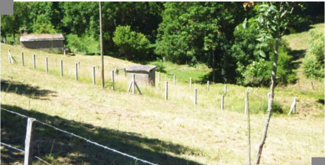
Photo 1 : exemple d'un périmètre immédiat clôturé. Le captage lui-même est abrité par le petit édifice maçonné.
